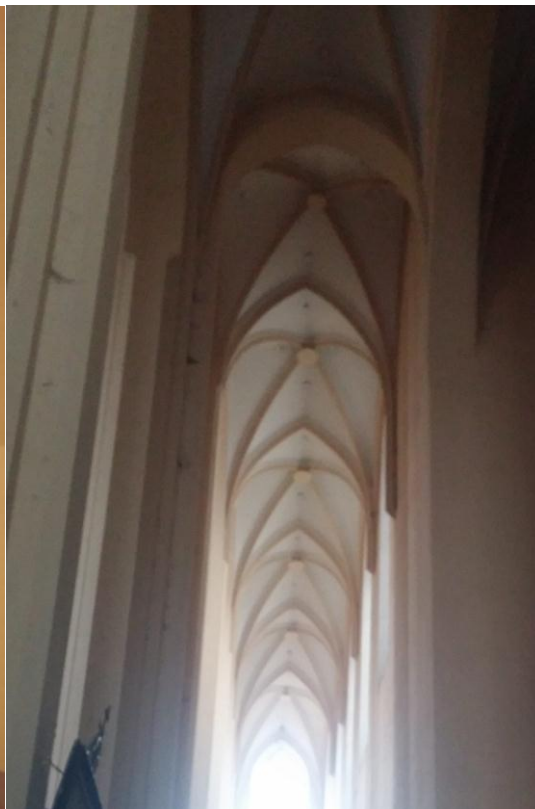
Sklepienie nawy bocznej kościoła
